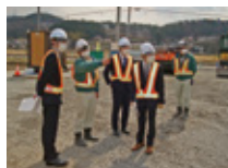
建築作業所での見学会の様子
