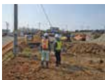
土木作業所見学会の様子
