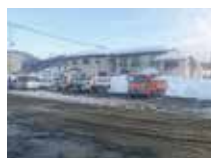
排出作業の様子
