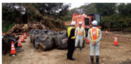
土木作業所での審査の様子
