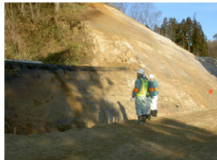
土木現場の安全パトロール
