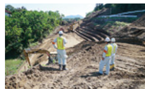
パトロールの様子(土木)
