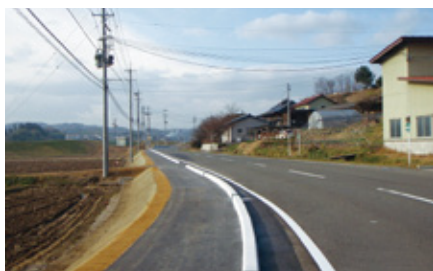
完成した作田・北杉田線歩道の様子
