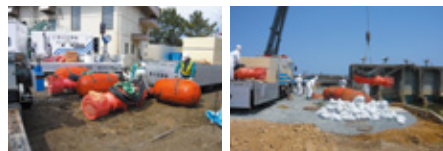
排水作業の様子
