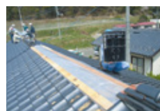
屋根での作業の様子
