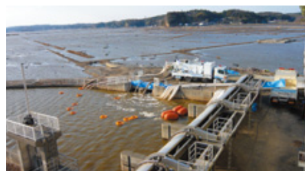
排水作業の様子
