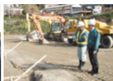
土木作業所での審査の様子
