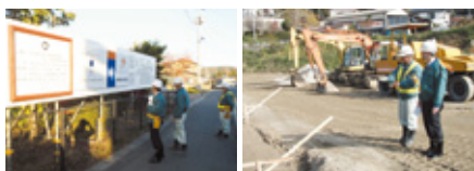
建築作業所での審査の様子
