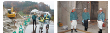
土木作業所での審査の様子
