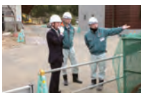
建築作業所での審査の様子
