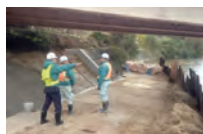
土木作業所での審査の様子
