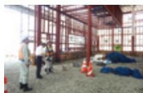
建築作業所での審査の様子
