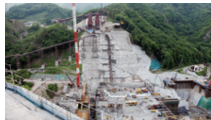
ハッ場ダム 工事現場
