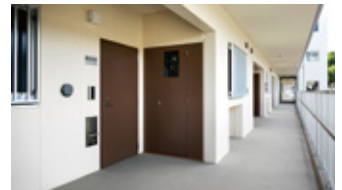
復興公営住宅 玄関前アルコーブ
