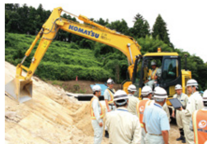
ICT建設機械による施工技術見学の様子
