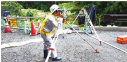
現場実習の様子
