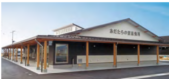
完成した大玉村産業振興センター・あだたらの里直売所
