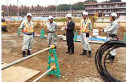
建築作業所での審査の様子
