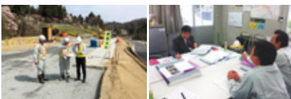
土木作業所での審査の様子
