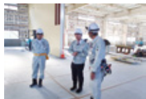
建築作業所での審査の様子
