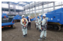
建築作業所での審査の様子
