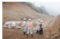
土木作業所での審査の様子
